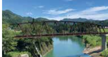
完成了恢復施工的 第七只見川橋樑
